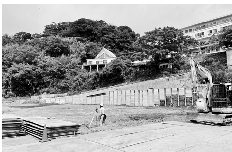
坂道の土留め工事
